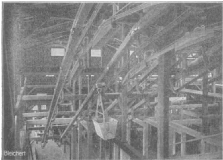
Abb. 12. Zwei Elektroseilbahnen, Patent Bleichert, zur Überwindung des Höhenunterschiedes zwischen der Werkssohle und dem Dachgeschoß einer Schuppenanlage.
